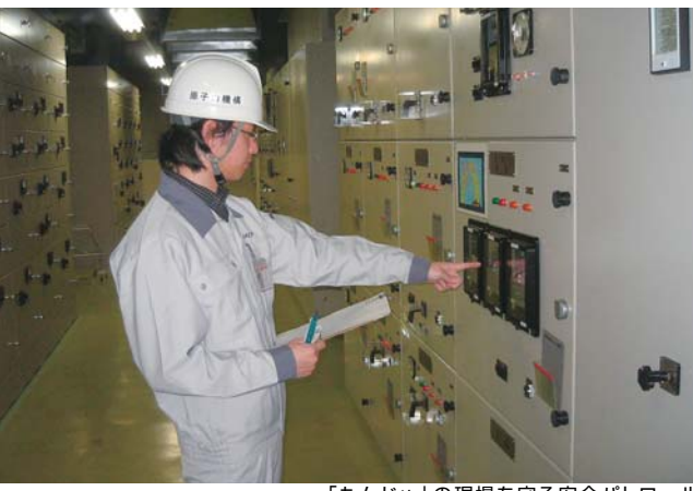
「もんじゅ」の現場を守る安全パトロール
